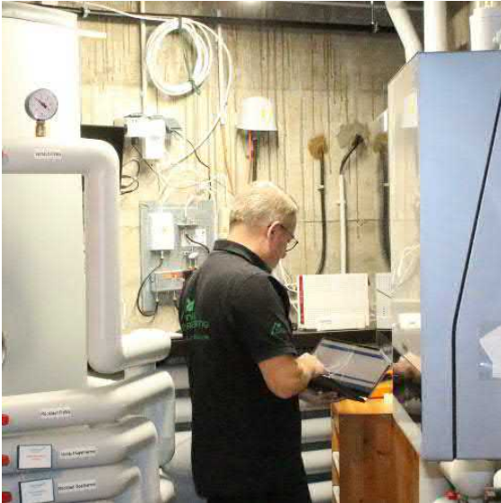
Gemeinsame Begehung des Gebäudes mit dem Energieberater
