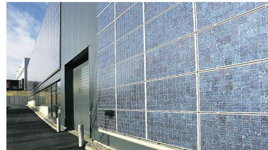
Recycelte Solarmodule sind kaum von neuwertigen zu unterscheiden. Das wird auch an der Fassade des neuen Produktionsgebäudes der Solar Material deutlich. Fotos (7): Solarpraxis AG
